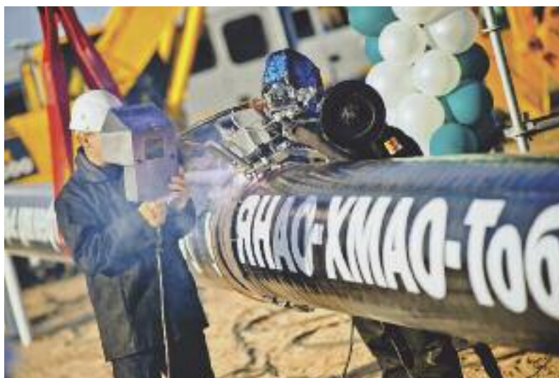
Строительство продуктопровода Пуровский ЗПК – Тобольский НХК
